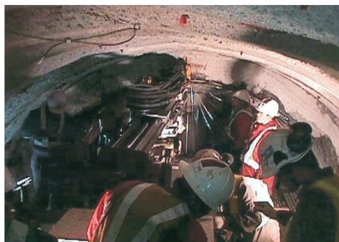
写真-3 削孔検層状況
