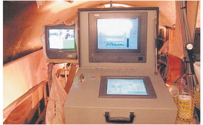
写真-2 TBM機側管理システム
