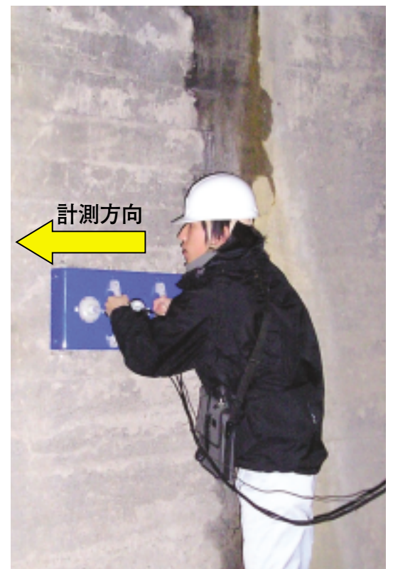
既設トンネルにおける計測(例)
