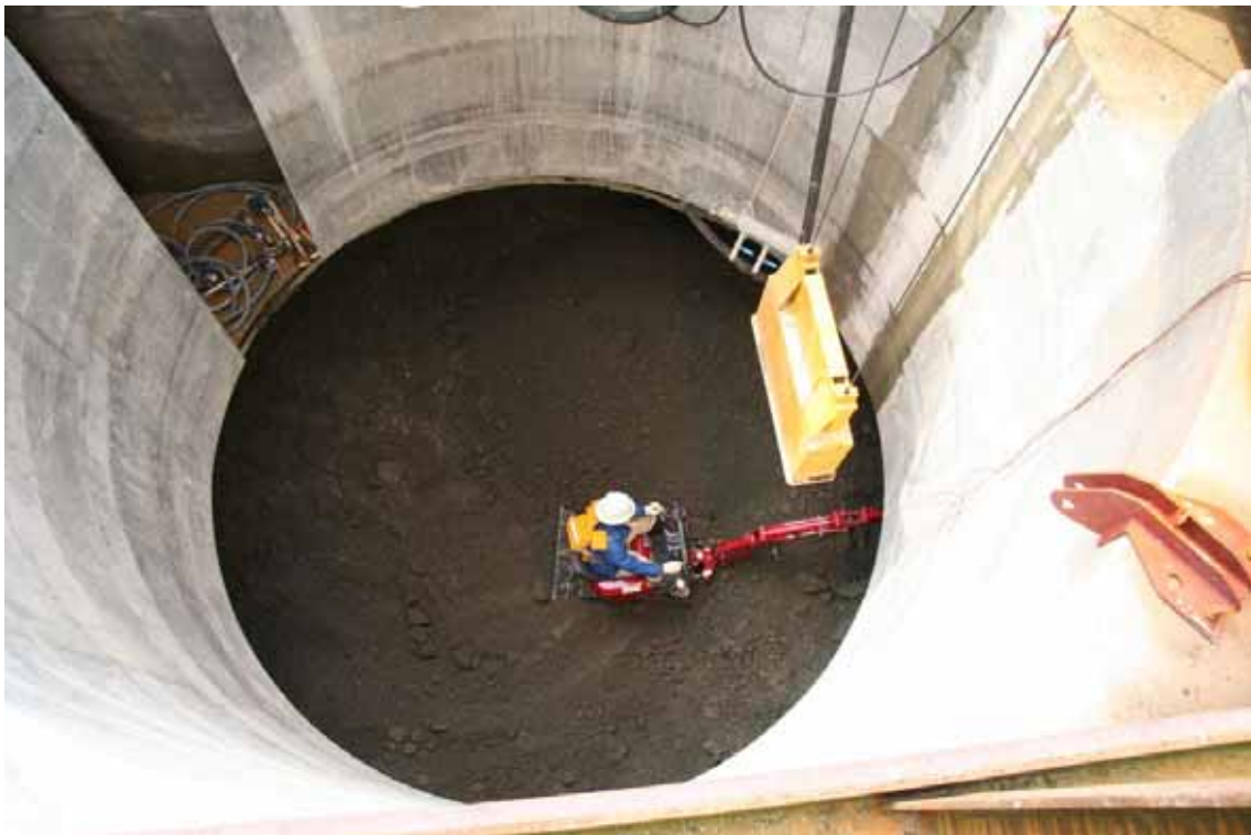
写真-2 換気立坑切羽 GL.-8m（坑口より H18.8.11 撮影）
