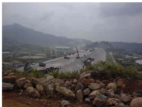
写真-5 RCCダム盛立て状況 1)
