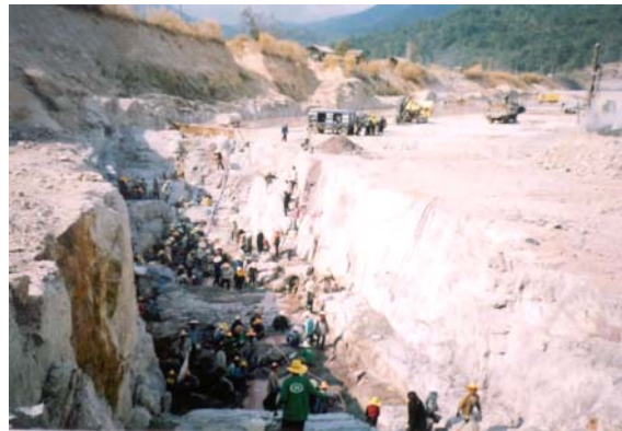
写真-4 基礎岩盤処理 1)
