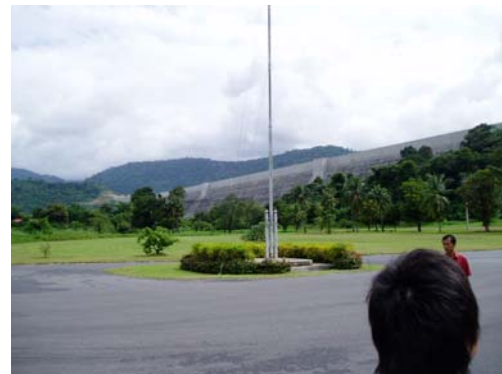
写真-2 タダンダム RCC 部遠望
