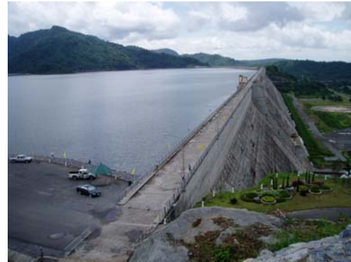
写真-1 タダンドムのダム部および湛水池の遠景
