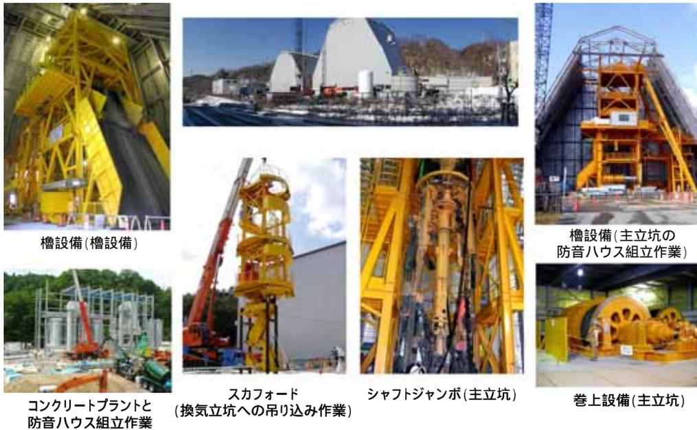
写真-1 研究坑道掘削工事の主要な設備と建設状況
