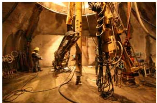
写真-2 シャフトジャンボによるグラウト注入孔の削孔状況（換気立坑接続部からボーリング横坑への削孔）
