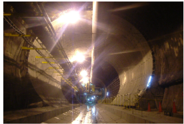
写真-3 アーチライナー施工状況
