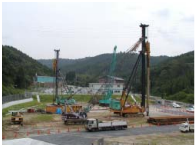
写真2 立坑坑口工事状況写真 (瑞浪)
