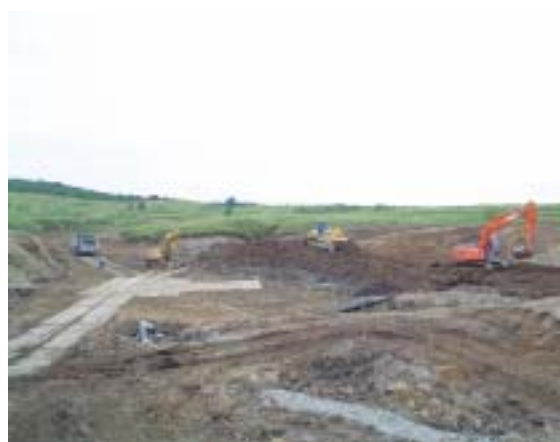
写真4 造成工事の状況写真（幌延）
