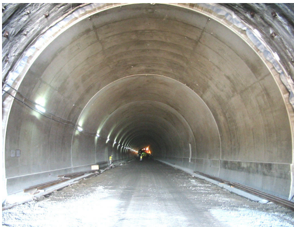
覆工コンクリート (坑口付近)
