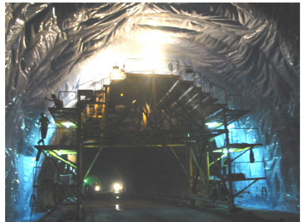
防水シート 施工状況
