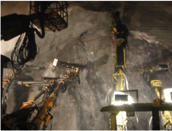
油圧ジャンボによる穿孔状況（本坑）
