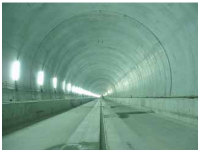
図 - 1 8 林口トンネル竣工状況
