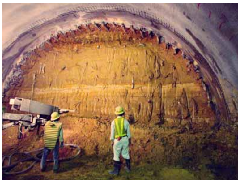
図 - 16 林口トンネル 微細砂層の掘削 (AGF, フェースボルトおよびシリカレジンを注入)
