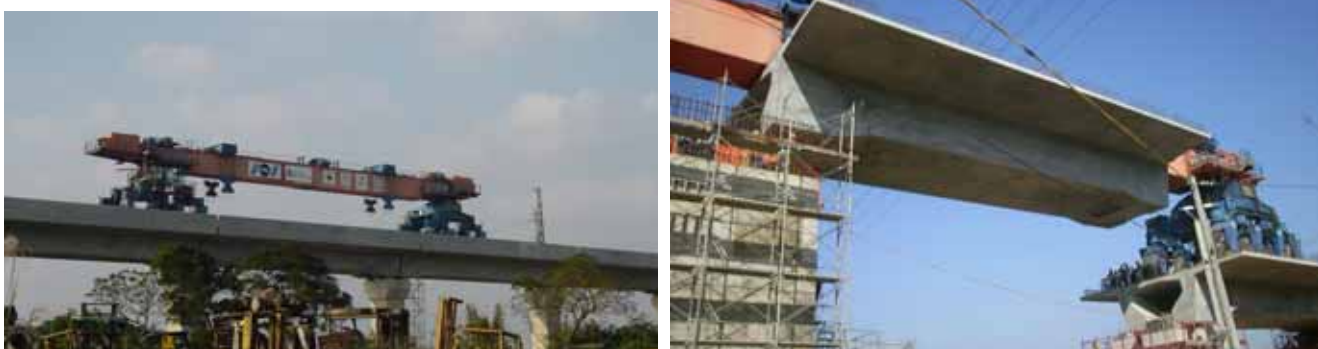
図 - 7 自走式キャリアによるプレキャスト桁の架橋
