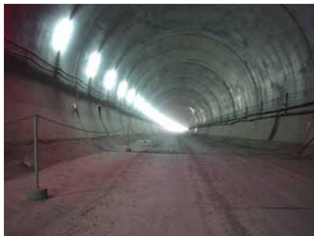
図 - 1 2 廻龍トンネル二次覆工施工
