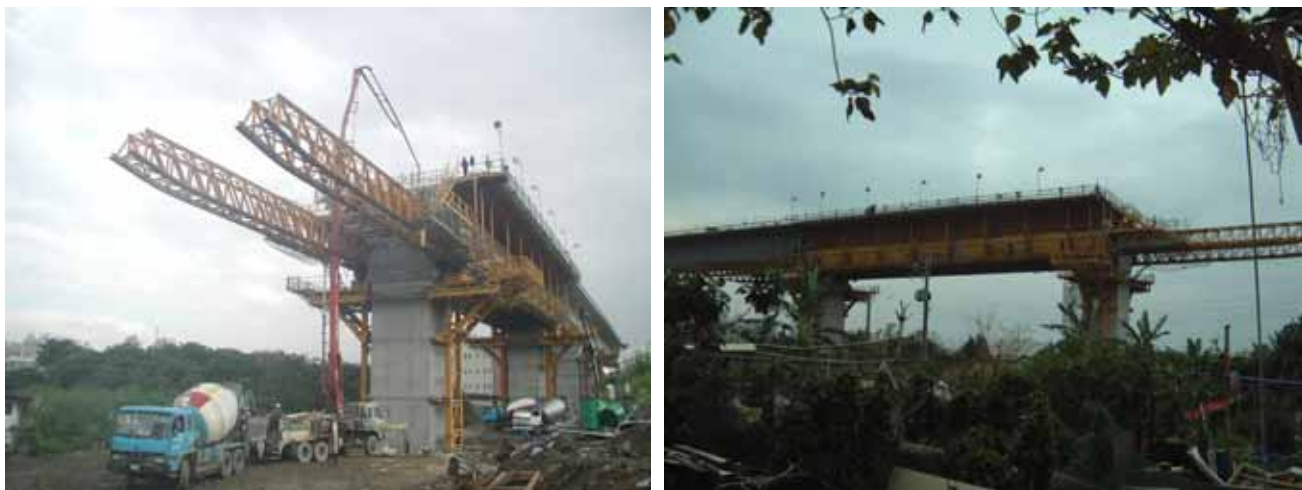
図 - 5 移動支保工による施工
