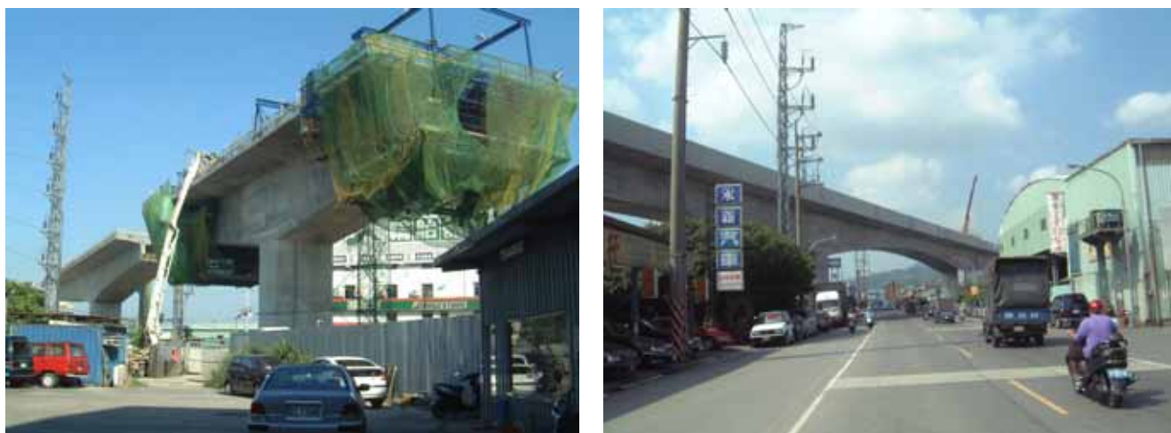
図 - 6 カンチレバー橋施工状況
