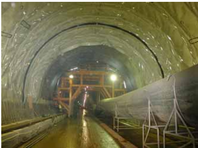
図 - 1 7 林口トンネル防水シート工
