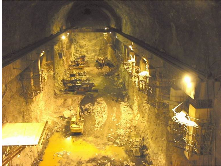
地下発電所掘削状況
