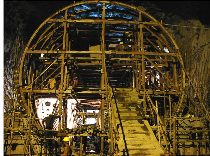
放水路トンネル
