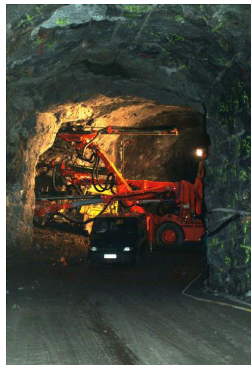
図-9 アクセス坑道の掘削状況（右図） （出典：Posiva 社の Web サイト）
