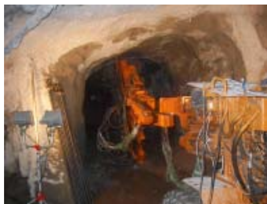
写真-2 試験貯槽の掘削状況
