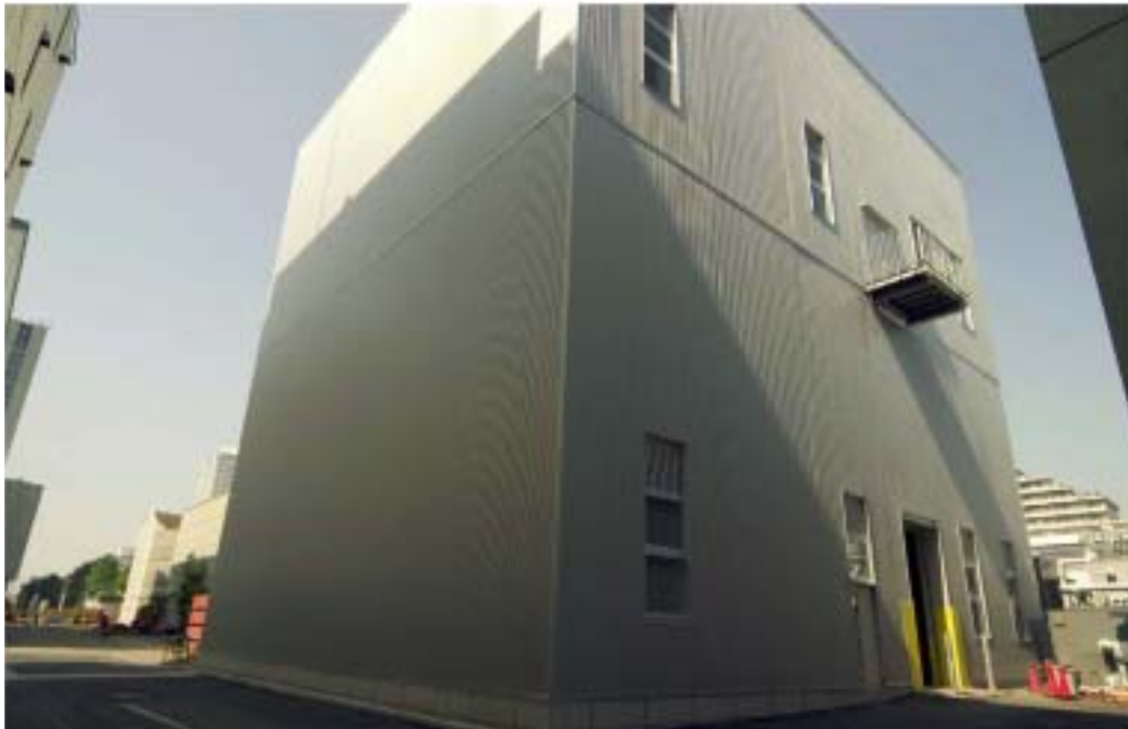
写真-1 新岩石実験棟の外観
