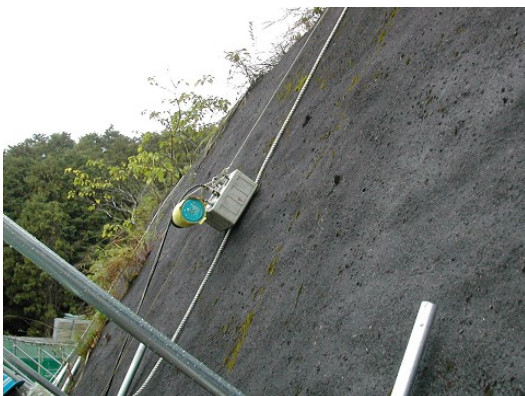
図6.3 パルス波地中レーダによる探査状況 4)
