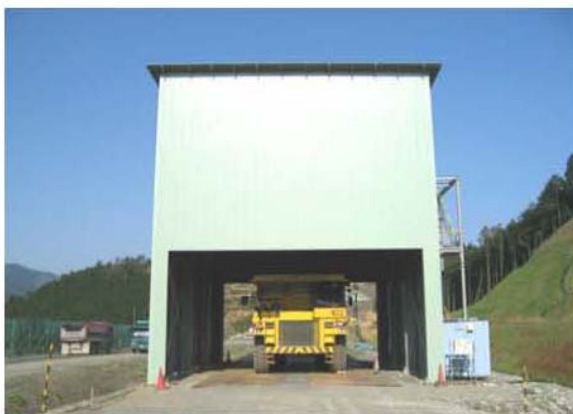
写真2.3 ダンプ撮影建屋全景
