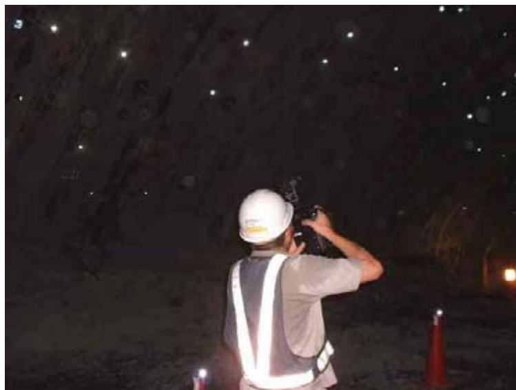
写真2.1 デジタルカメラによるトンネル内空変位計測の撮影状況
