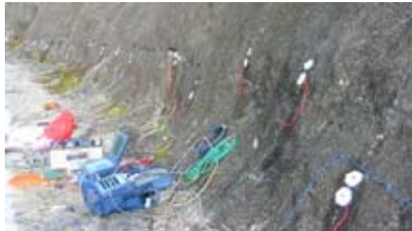
図6.16 ジオゲル電極と測定状況 4)
