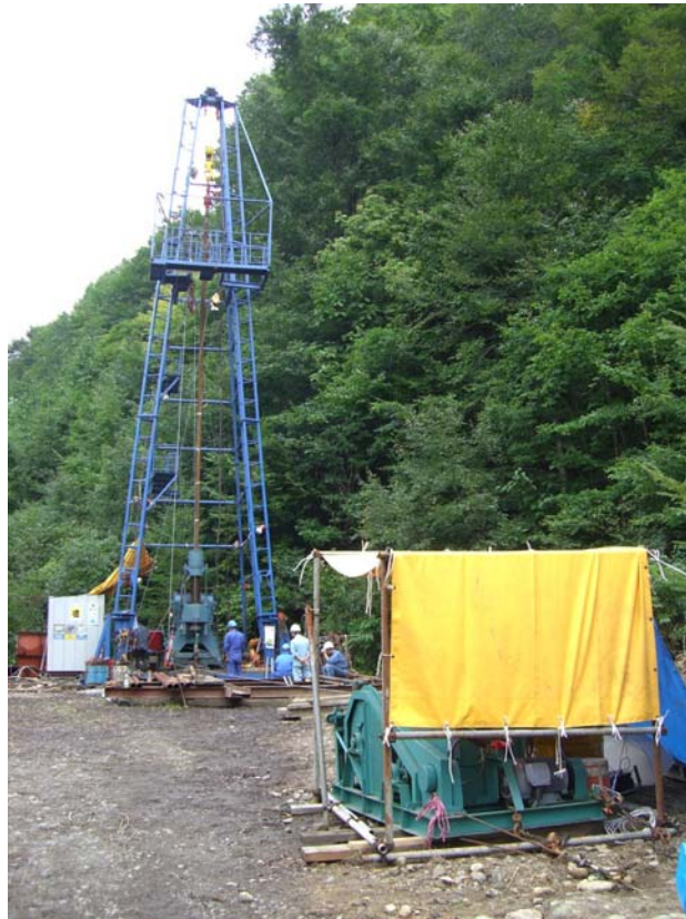
図3.8 実証試験現場の状況 2)
