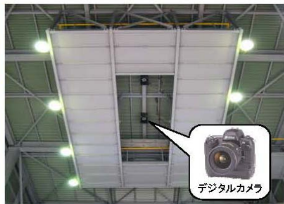
写真2.4 撮影建屋内部
