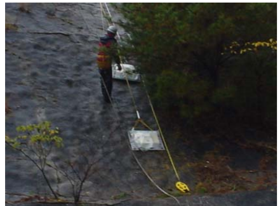
図6.4 連続波地中レーダによる探査状況 4)
