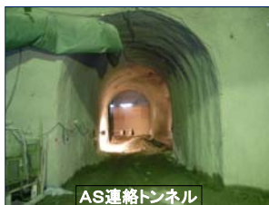
AS連絡トンネル
