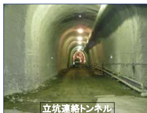
立坑連絡トンネル
