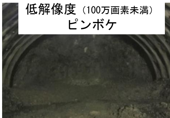
写真 不適当と考えられる切羽写真の例
